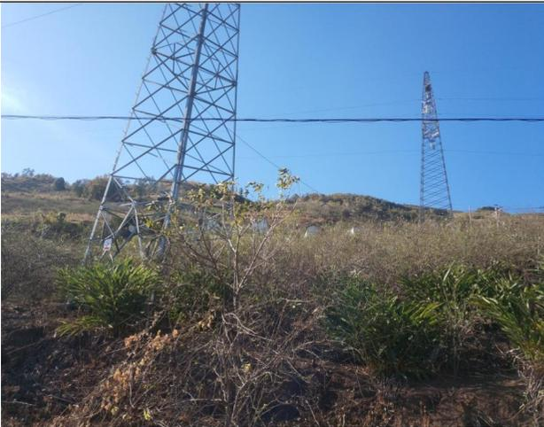
图 5-7 塔基原施工裸地植被恢复良好
