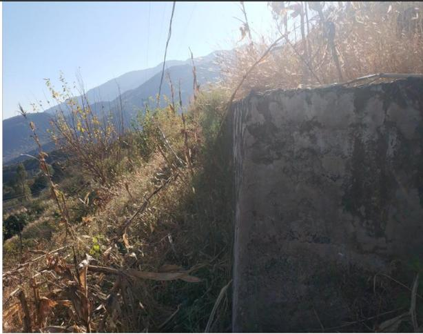
图 5-5 塔脚基础混凝土护面
