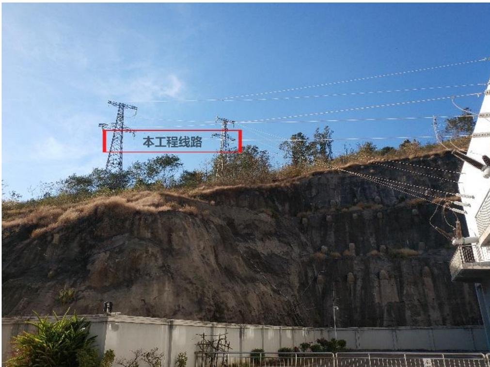
图 4-7a 白鹤滩 110kV 变电站外本工程线路走向
