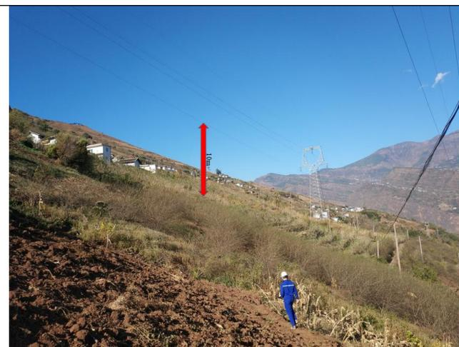
图 5-4 输电线路跨越农田段最大弧垂高度大于 7m
