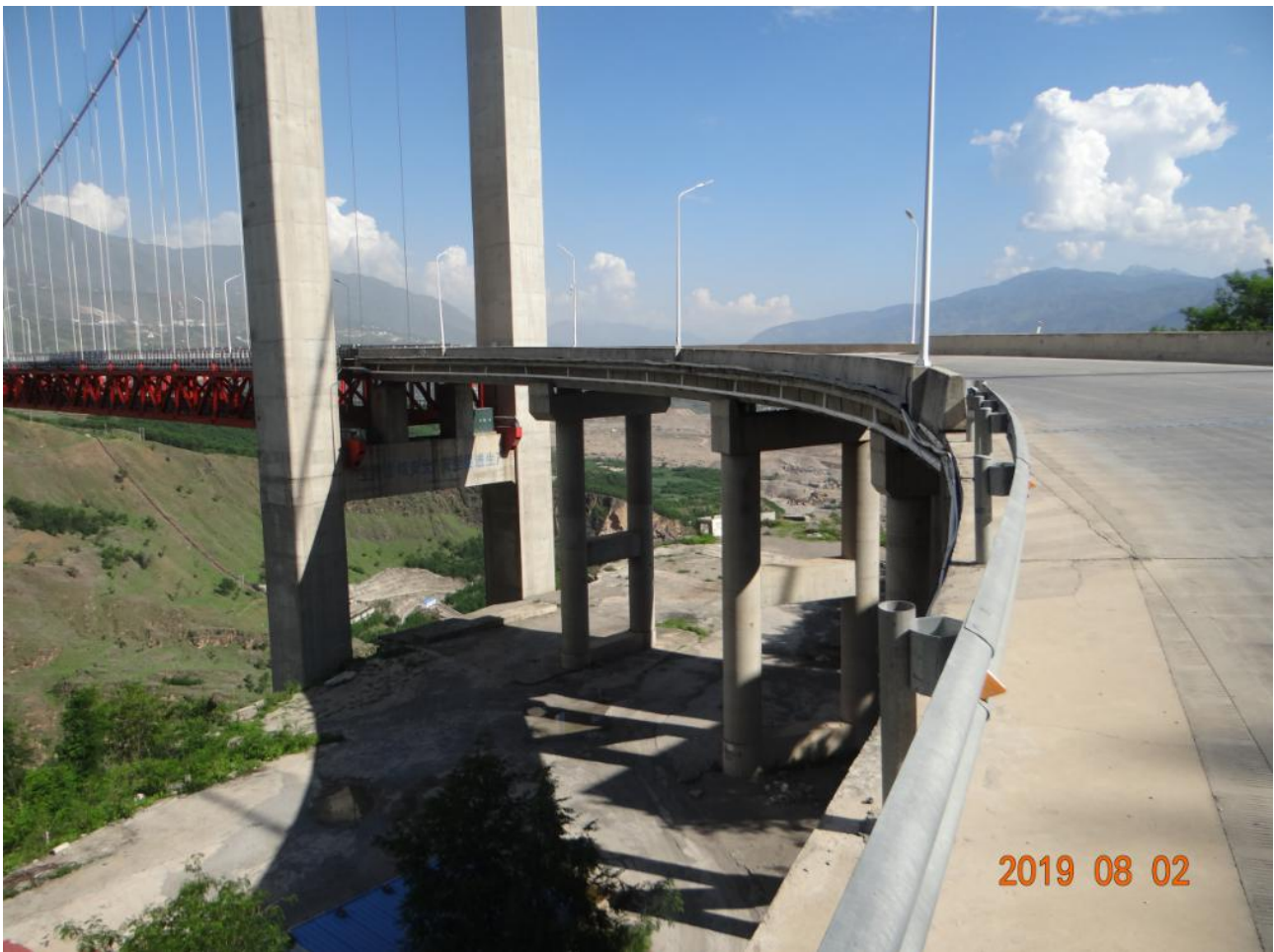
图 7-5 已完工的桥面径流系统
