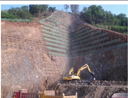
施工中边坡排水沟、绿网防护
