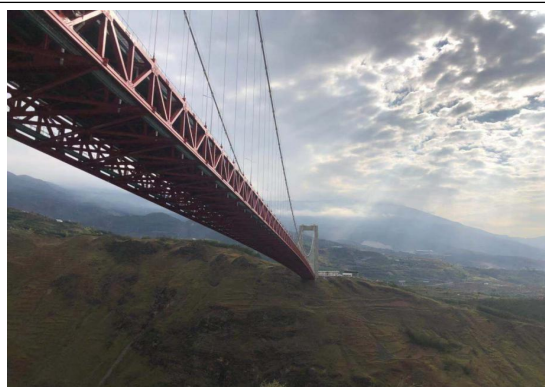
图 5-4 大桥施工坡面植被恢复良好
