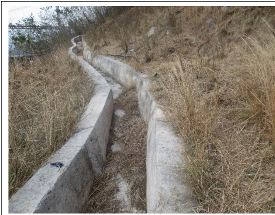
弃渣场截、排水沟
