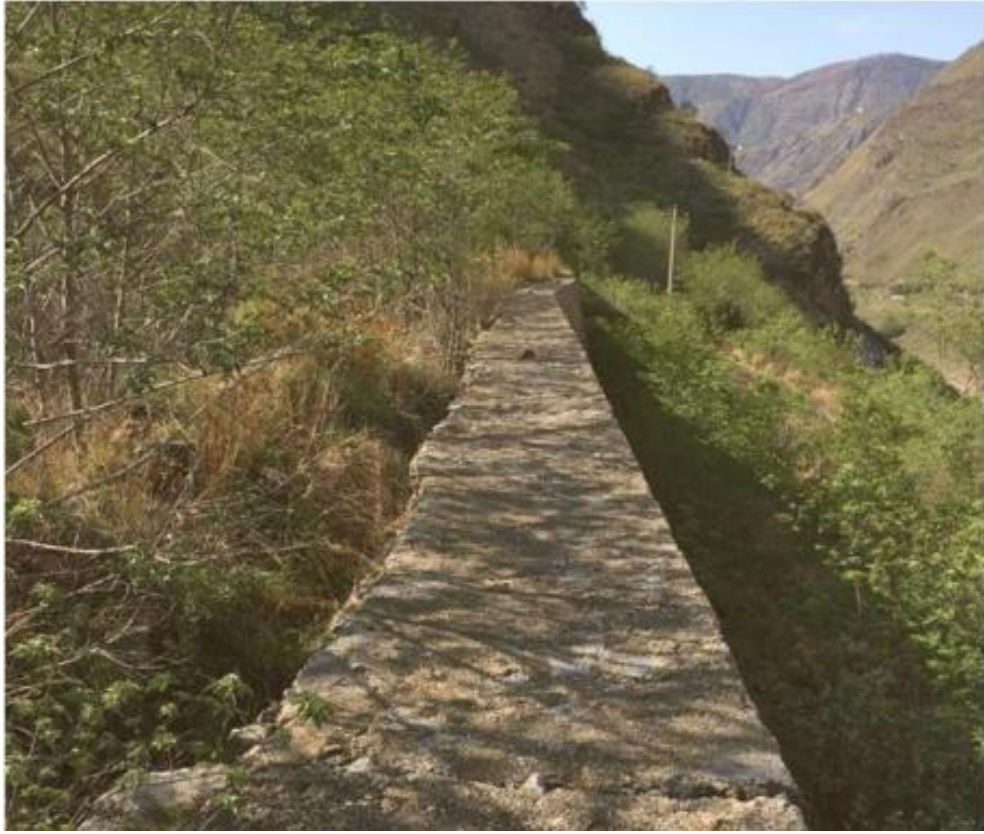
老蟒蛇沟弃渣场挡墙
