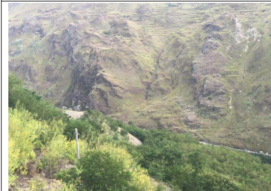
图 5-3 施工场地植被恢复良好
