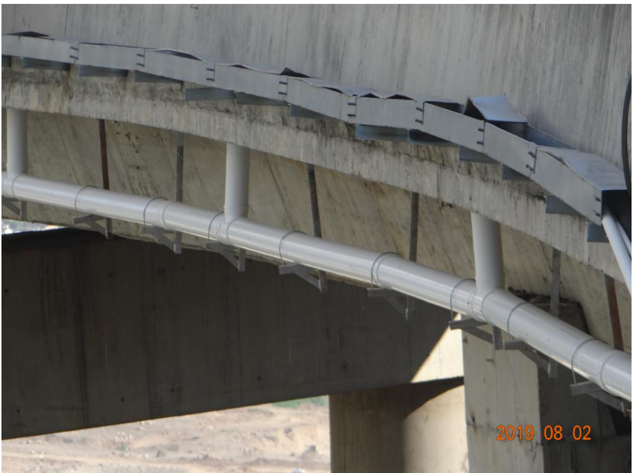
图 7-4 已完工的桥面径流系统
