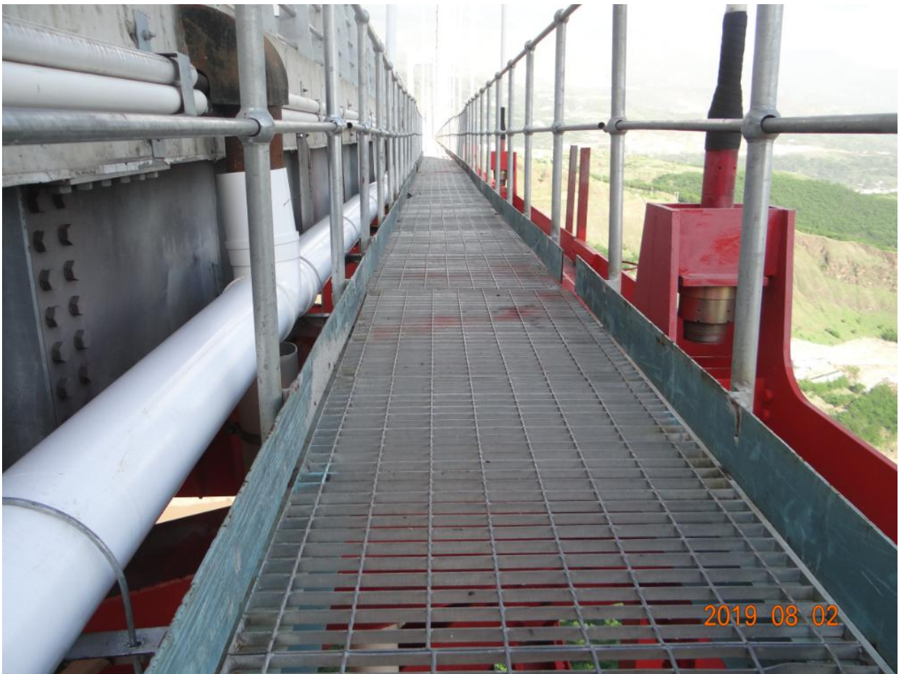
图 7-3 已完工的桥面径流系统
