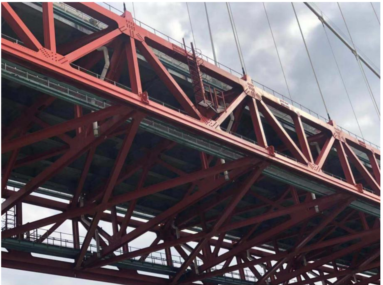
图 7-2 正在施工中的桥面径流管道系统
