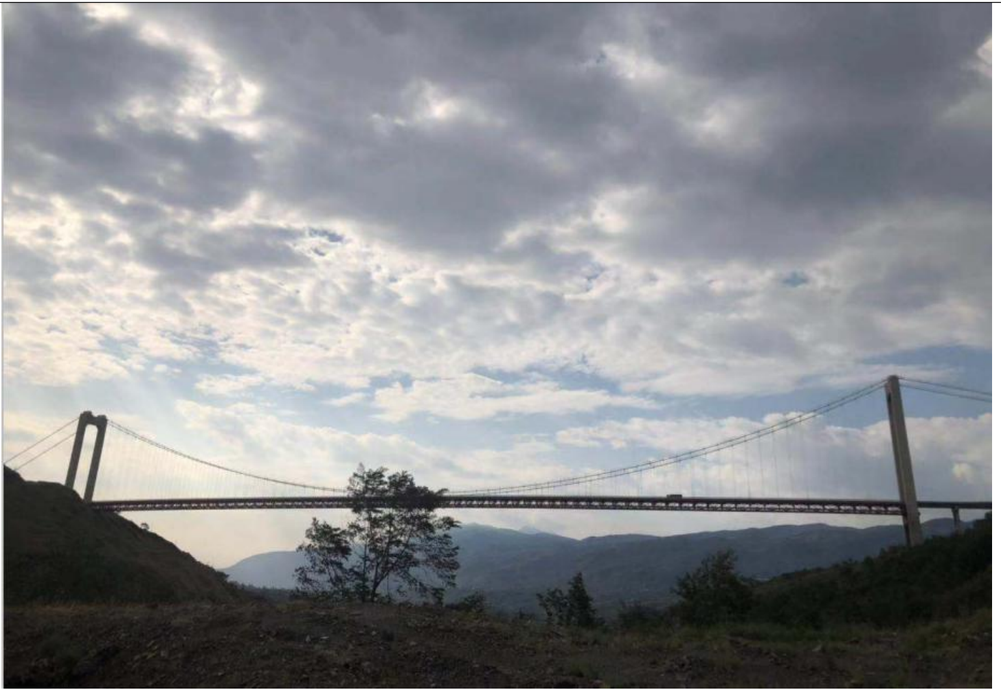
图 2-4 葫芦口大桥工程
