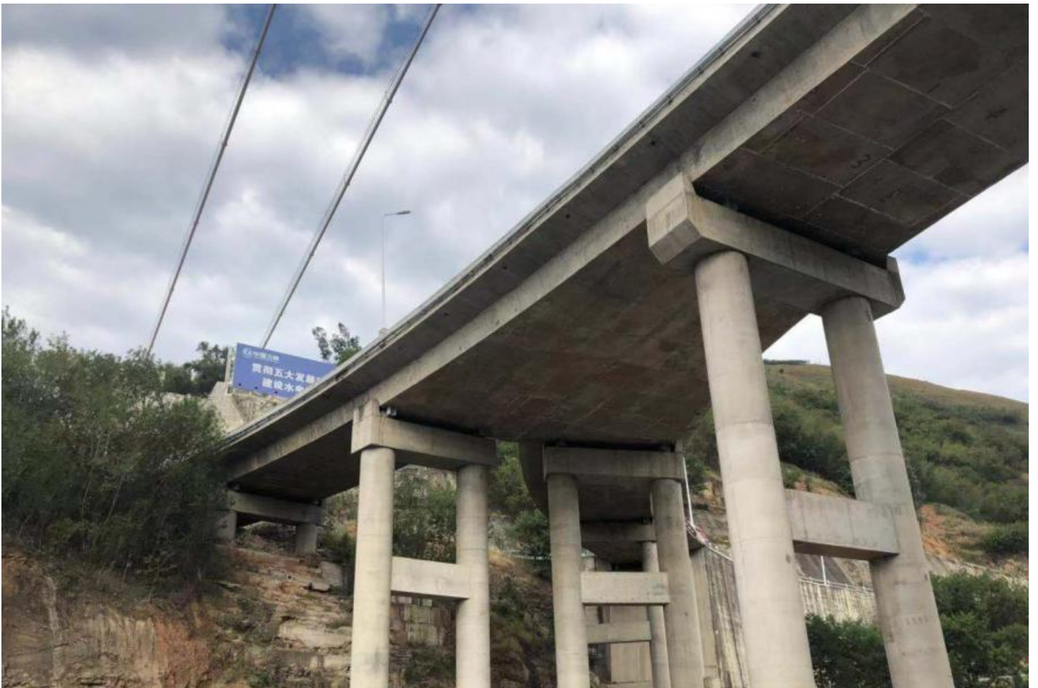
图 2-5 葫芦口大桥引桥工程
