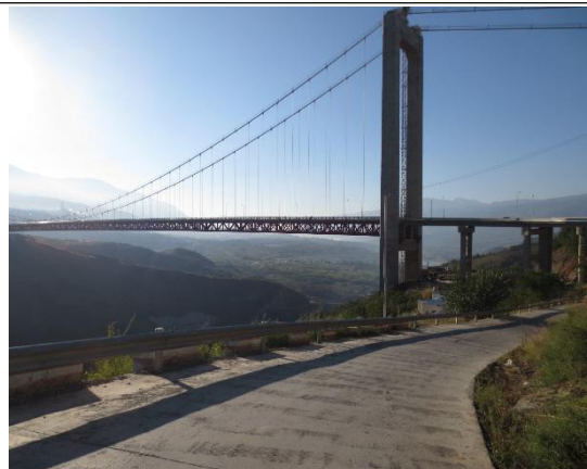
施工便道平整、硬化
