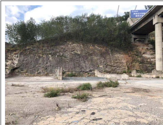
图 5-1 施工场地拆除
